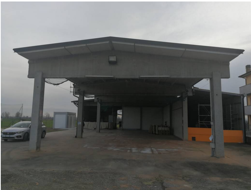
Fotografia nr. 4 – Struttura prefabbricata oggetto di intervento
